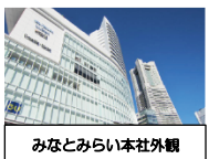
みなとみらい本社外観
